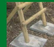
Betonbodenplatten als trockene, feste Unterlage 40 x 40 cm (4 Stück)
